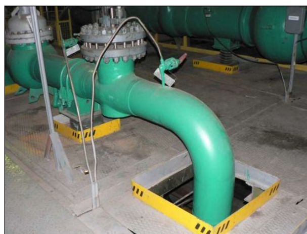
Выявленная зона кавитационной эрозии (дефект утонения стенки трубы)
